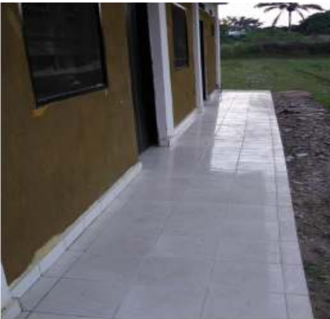
Sanering Bloc Opérateur, buitenzicht
